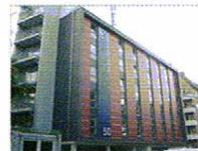
Zülpicher wall 70 50674 Köln-
