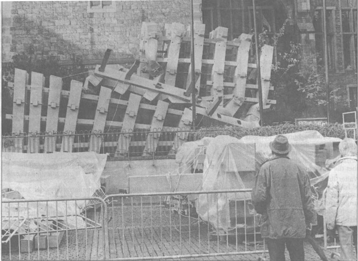
Vom Wind geknickt, vom Regen durchweicht: Die Pappnachbildung der Reimser Kathedrale hielt schon im Aufbau dem Öcher Wetter nicht stand. Heute wird das „Alpapier“ entsorgt. Foto: Michael Jaspers
